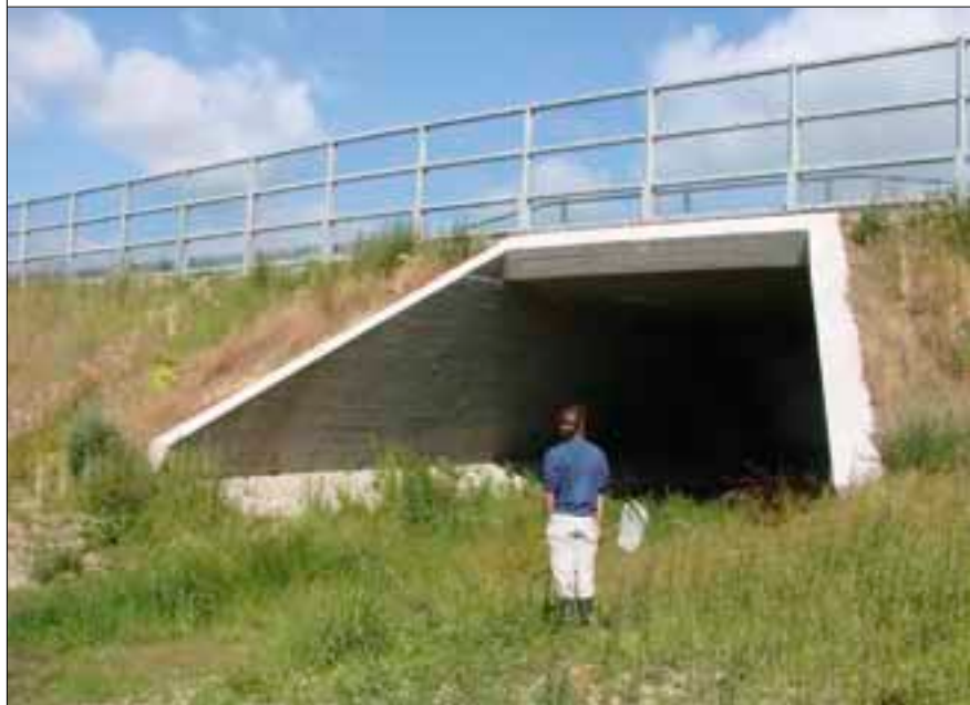
Figur 1-15 Faunapassage for Lisbjerg Bæk under den nyanlagte Djurslandsmotorvej. Faunapassagerne ved letbanens krydsning af Lisbjerg Bæk samt ved krydsning af det nordlige tilløb til Egå ved Parallelvejen vil blive udført efter samme principper.
