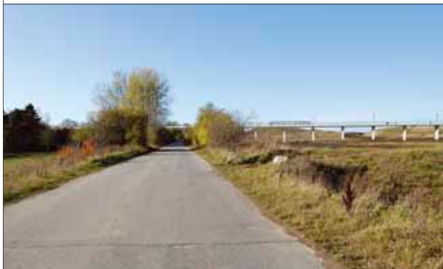
Letbanens forløb på høj dalbro over Egådalen, Gl. Søftenvej.
