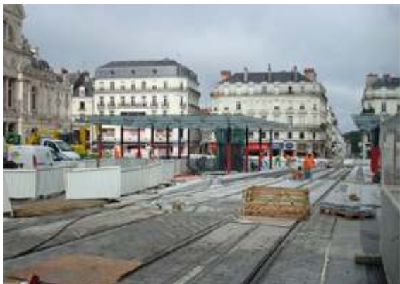
Foto: Anlæg af letbanens tracé (letbanespor) på en af Ångers' centrale pladser.
