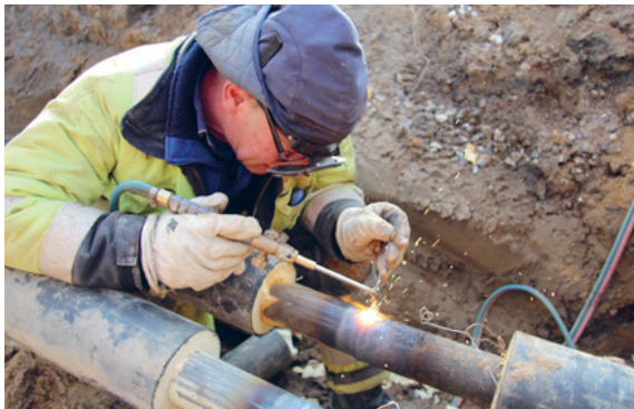
Foto: En stor mængde kabler og rør skal flyttes under jorden i og omkring Randersvej for at skabe plads til busbaner og letbane (Kilde: Svend Emil Mosbæk, Aarhus Kommune)
