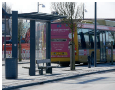
De eksisterende læskærme giver ikke tilstrækkelig læ for regn og vind.
